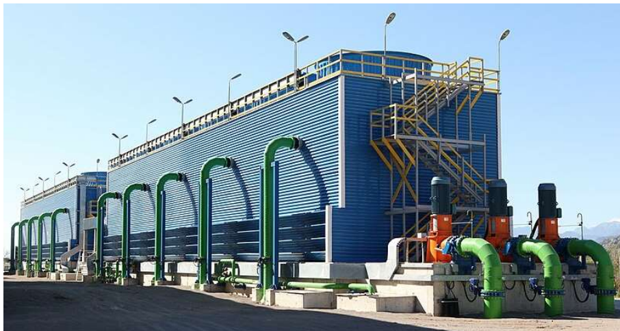
Figur 18: Et moderne kjøletårn med som bruker både vifter og kjølevann. Foto: Cenk Endustri (Wikimedia Commons).
